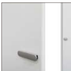
エナメル塗装を施し、表面材と一体感をもたせたエッジ部
