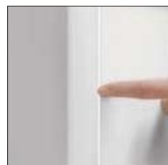
指をはさみにくいよう小さく抑えたドアの吊り元とパネルのすき間
