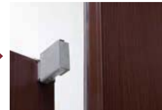
非常解放装置付きの錠を解錠すると内開きのドアが外側に開きます
